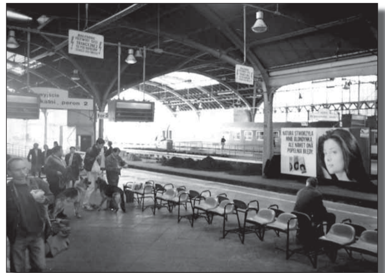
Współczesne zdjęcie wielkiej hali dworca wrocławskiego sfotografowanej z okna pociągu.
