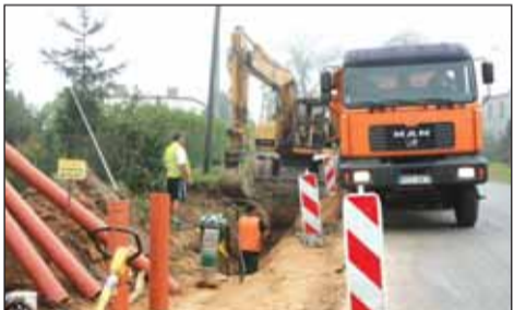
Sękowo – budowa kanalizacji
