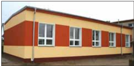
Odnowa wsi Podrzewie – remont świetlicy wiejskiej
