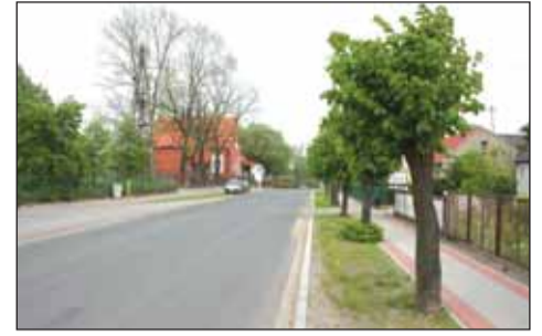
Remont drogi w Sędzinku
