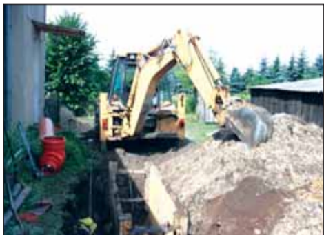
Ceradz Dolny – budowa kanalizacji
