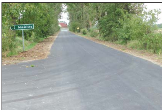
Droga powiatowa Młynkowo Sarbia.
