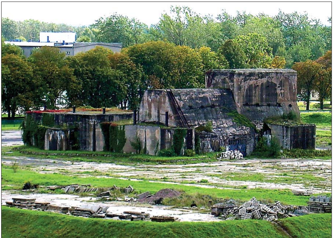
Tajemniczy obiekt żelbetowy z czasów Focke-Wulf Flugzeugbau GmmH Werk Posen stoi na lotnisku wojskowym w Poznaniu-Krzesinach. FOT. (2X) – LESZEK ADAMCZEWSKI
