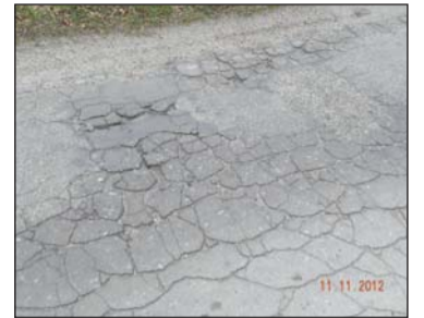
Zniszczona droga Zajączkowo-Psarskie
