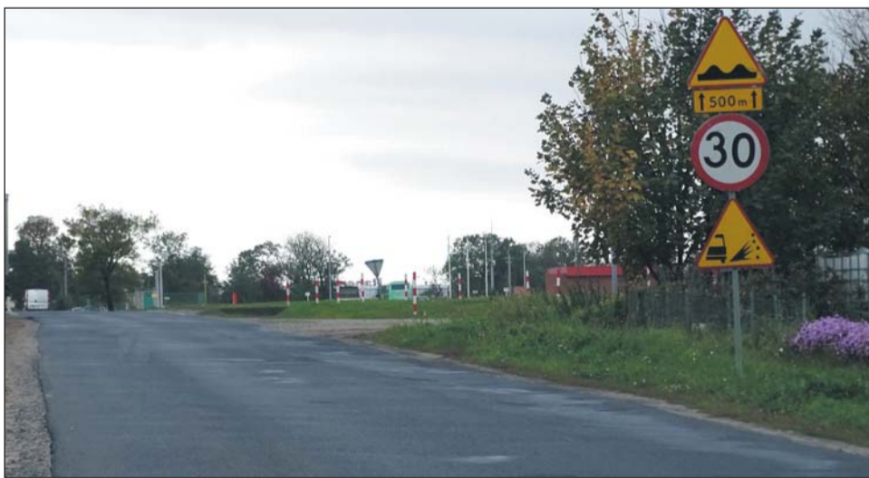
Droga od S11 do Dachowej, gmina Kórnik
