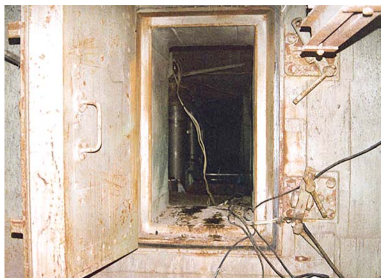
Wnętrze elektrowni w Czarnobylu.
