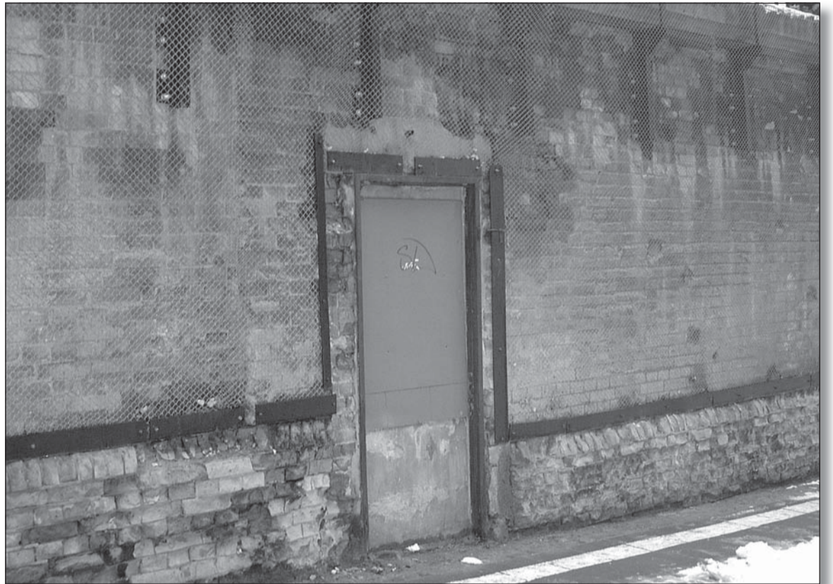
Zamurowane wejście do schronu przy ulicy Zamkowej.
